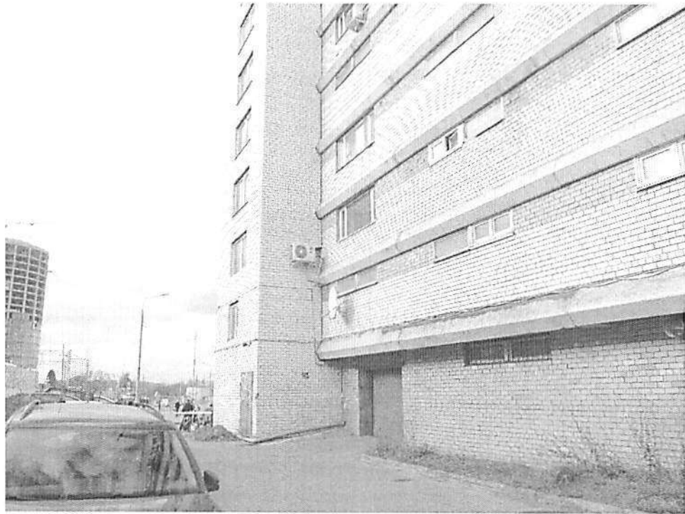
Фото 1.1. Общий вид пристроенной лестницы № 1.
