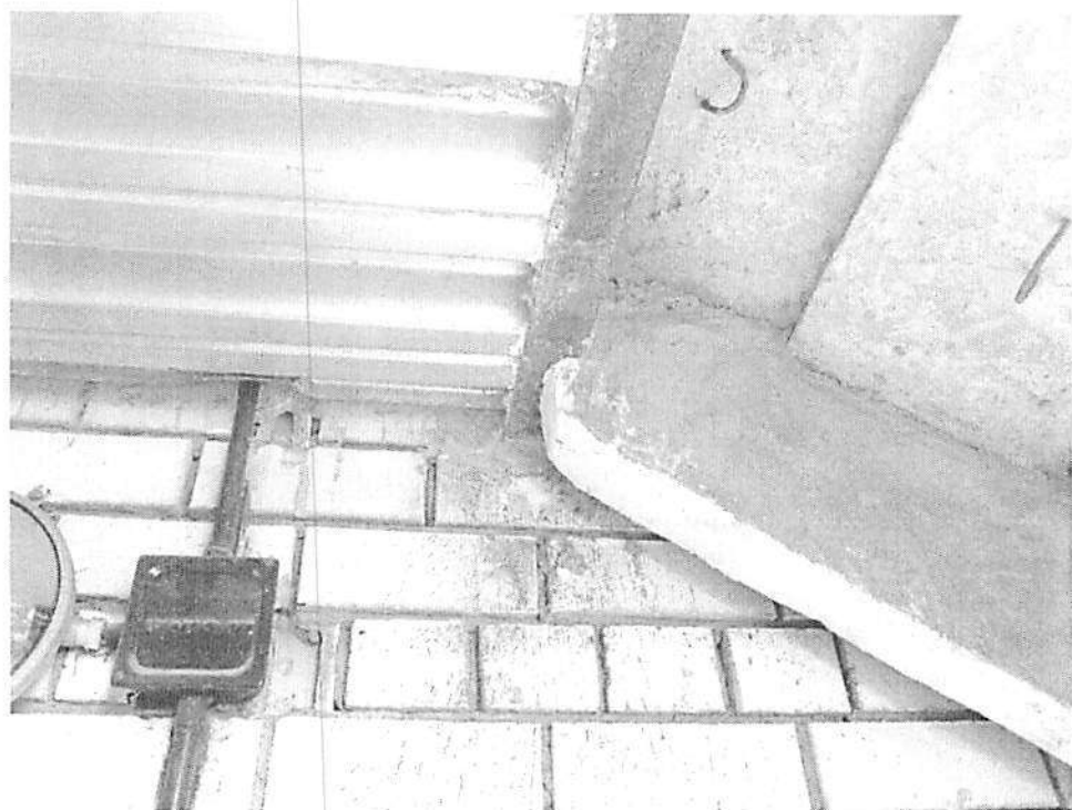
Фото 3.9. Несущие элементы лестничной клетки.
