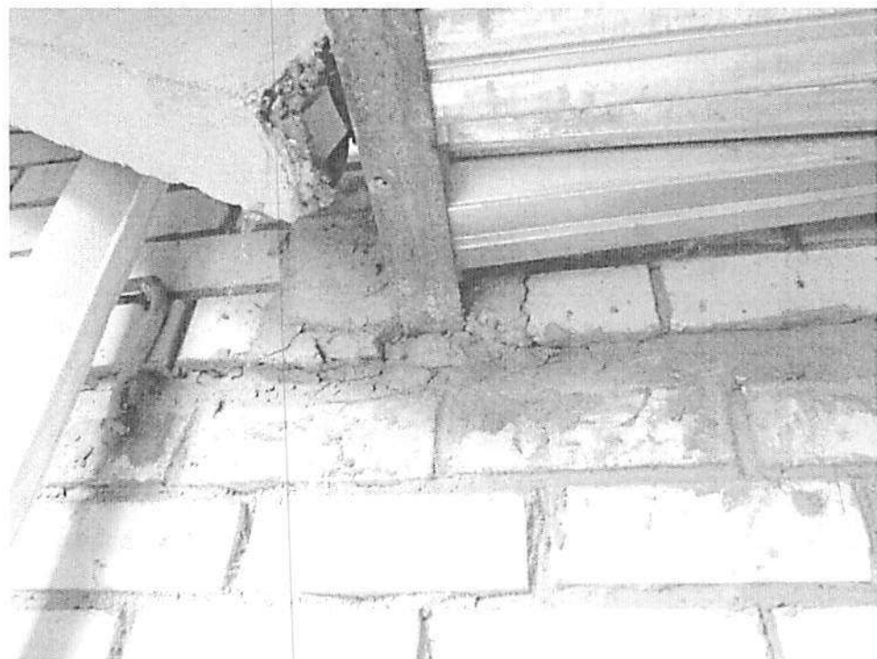
Фото 3.10. Опираие стальных балок лестничной площадки на кирпичную стену.
