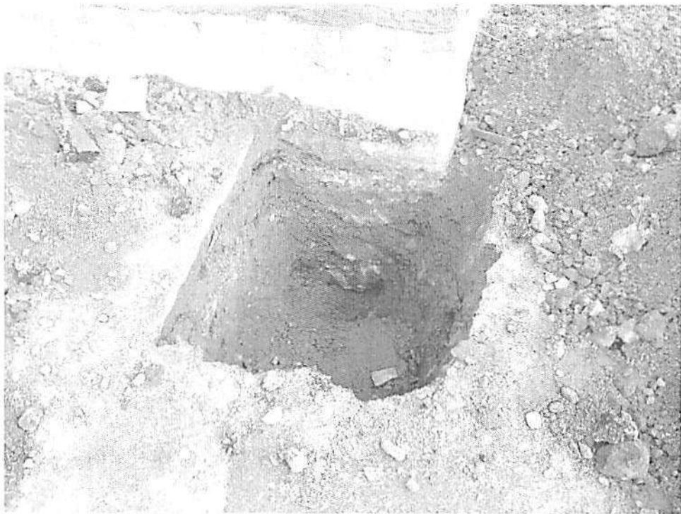
Фото 2.3. Общий вид шурфа № 2 лестницы № 2.
