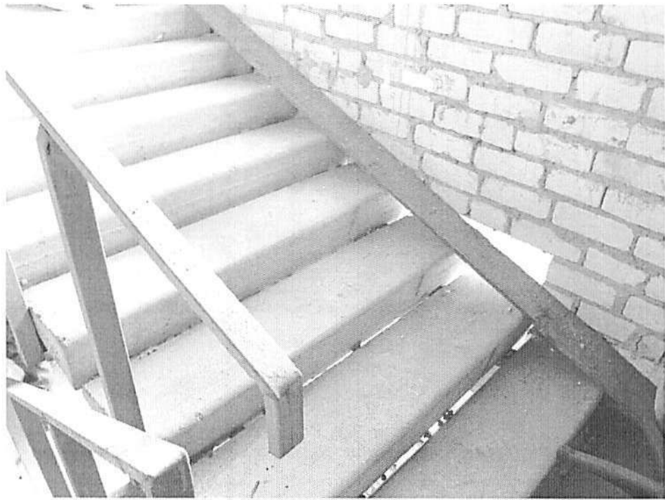
Фото 1.3. Общий вид и состояние лестничного марша.
