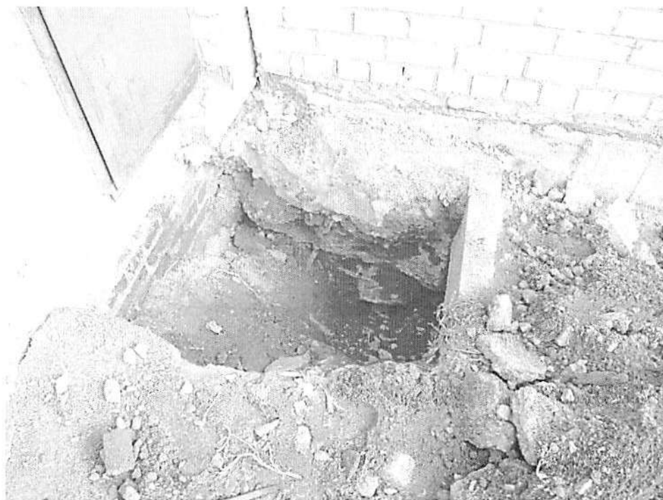
Фото 2.5. Общий вид шурфа № 3 лестницы № 2.
