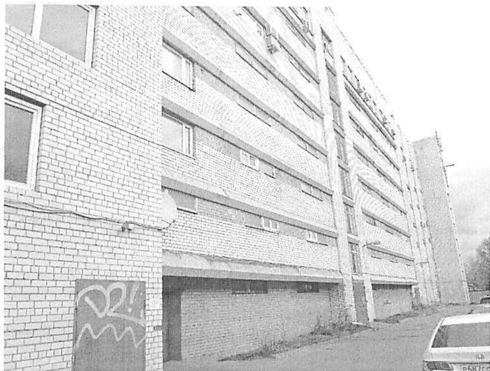
Фото 3.1. Общий вид пристроенных к основному зданию эвакуационных лестниц.
