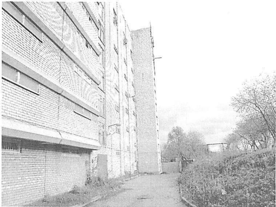
Фото 1.2. Общий вид пристроенной лестницы № 2.
