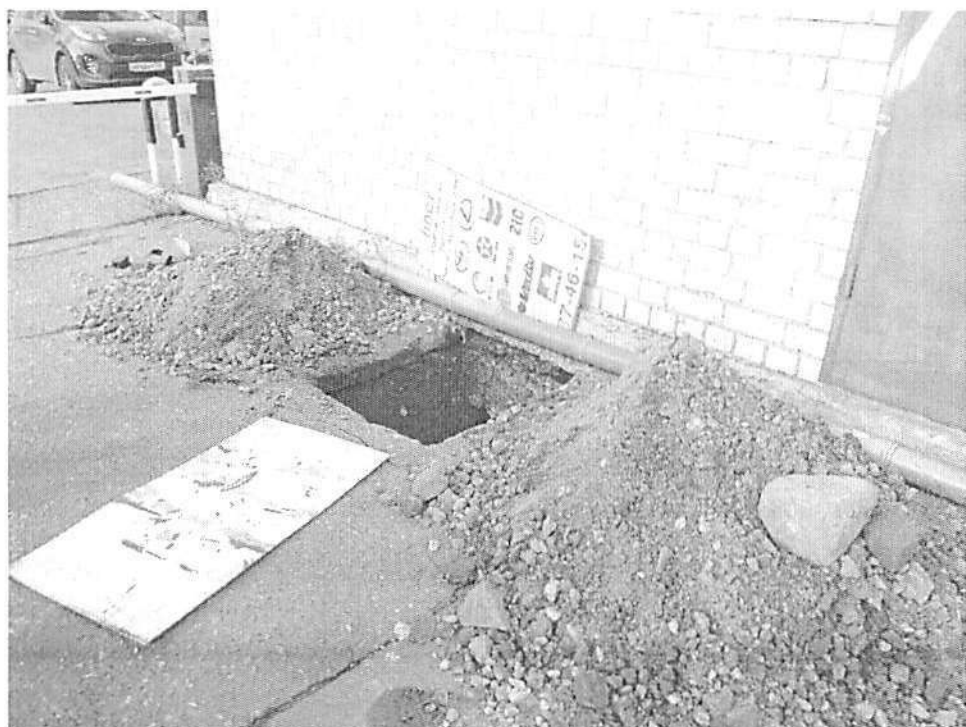
Фото 2.1. Общий вид шурфа № 1 лестницы № 1.
